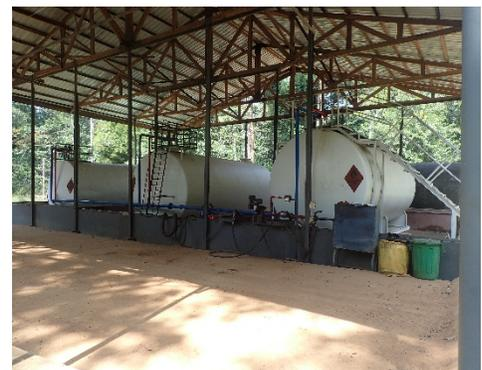
Figure 21 : Changement de la tuyauterie et peinture des cuves à Charlie 4
