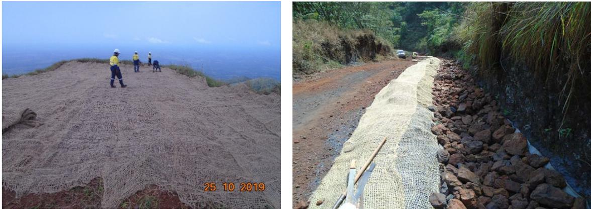
Figure 13 : La pose des jutes net pour la stabilisation du sol
