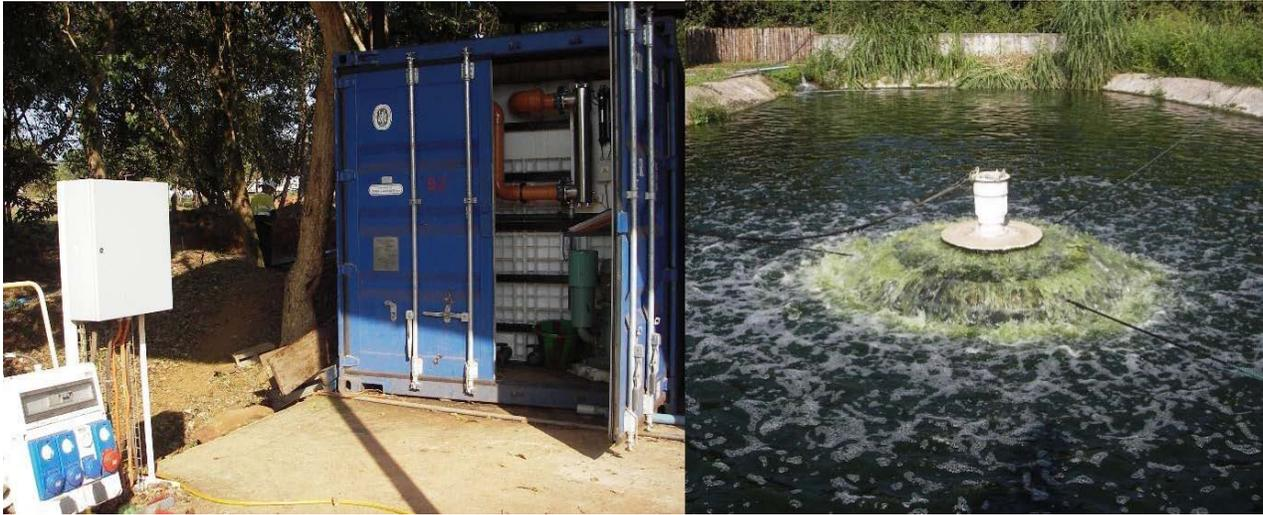
Figure 14. Biokube et aérateur aux lagunes pour le traitement des eaux usées (Cité 1/camp principal)
